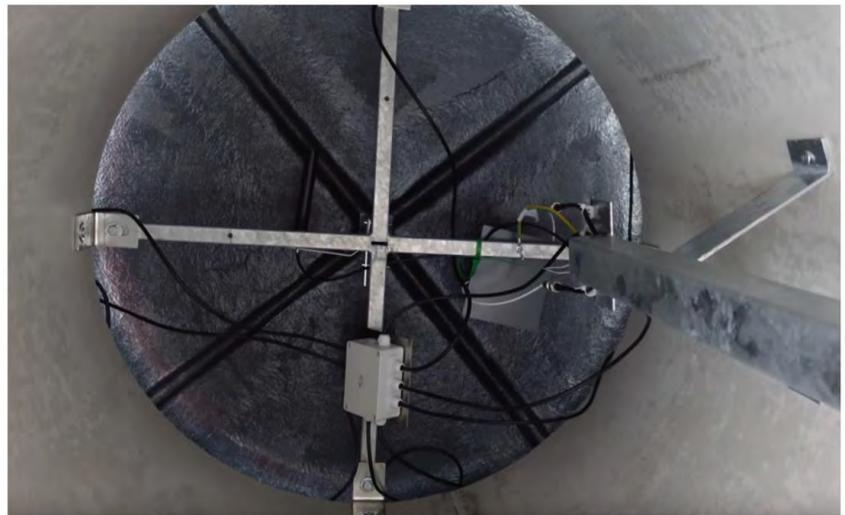
Fig. 10: Antena LTE en el techo del pilar publicitario [10].
