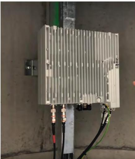
Fig. 9: Tecnología del sistema LTE en el interior del pilar publicitario; las líneas de alta frecuencia conducen a la antena en el techo [10].
