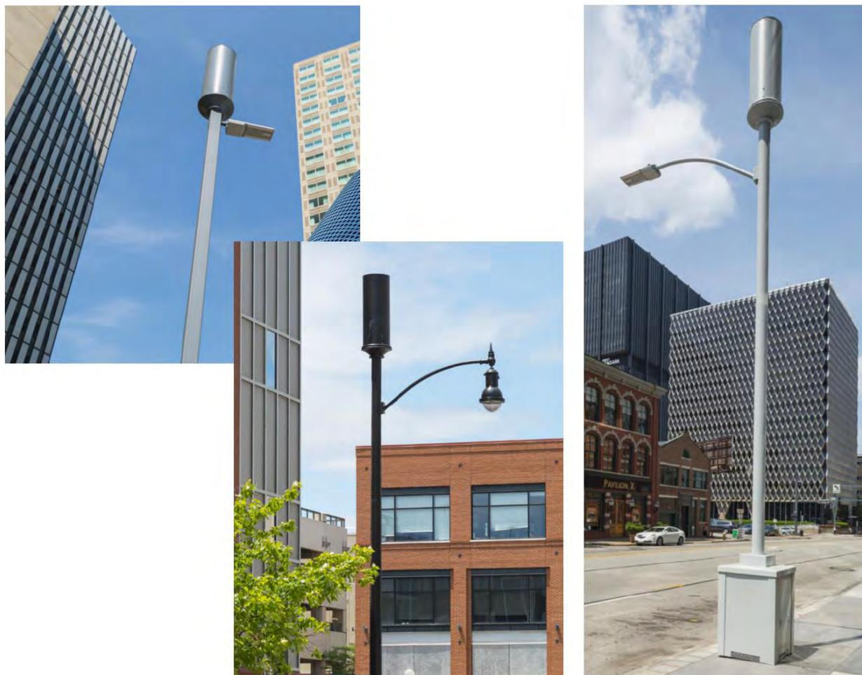
Fig. 5: "Recubrimiento InvisiWaveTM " alrededor de las celdas pequeñas en farolas [5]
